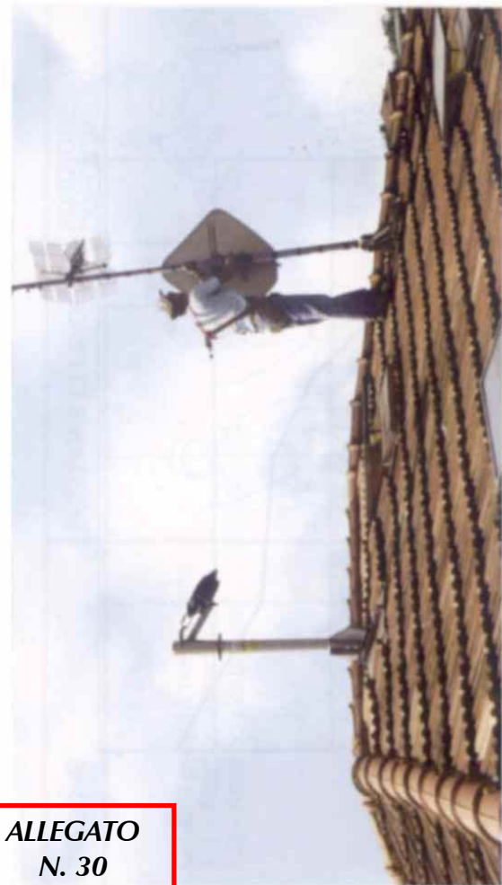
Utilizzo DPI, arresto caduta con punto di ancoraggio puntiforme.
